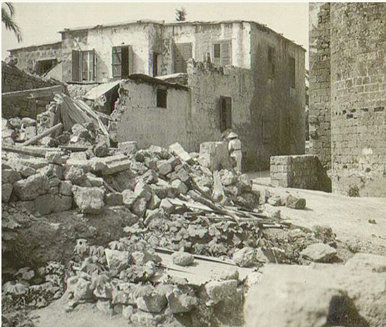
Αμμώωστος 12 Ιουλίου 1941. Καταστροφή ιδιωτικής κατοικίας από άμεσο χτύπημα στην παλιά πόλη. Πηγή: Κρατικό Αρχείο Κύπρου: SA1:516/1941.
